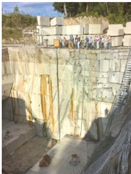
2016 – Betriebsbesichtigung Eggenberger Steinbruch, Eschenbach.
