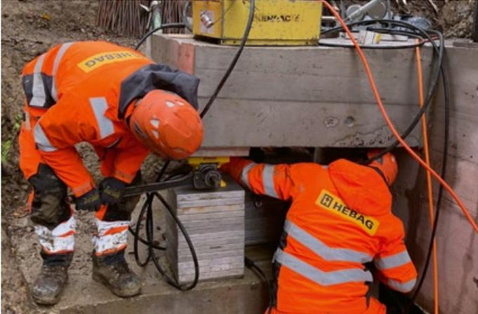
Die umfassende «Senkelstellung» des Gebäudes ist eine ingenieurtechnische Herausforderung. Vorerst galt es, eine umfassende Verstärkung der bestehenden Foundation zu erreichen, um dann die extreme Schräglage zu beheben, erklärt Bauingenieur Roman Blöchlinger. Eine neue Bodenplatte (innerer Kranz) wurde mit einem äusseren Stahlbetonkranz verbunden und bildet zu-
