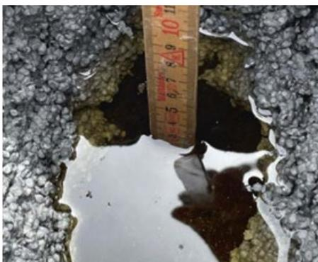
Das Wasser innerhalb der Isolationsschicht steht mehrere Zentimeter hoch.
